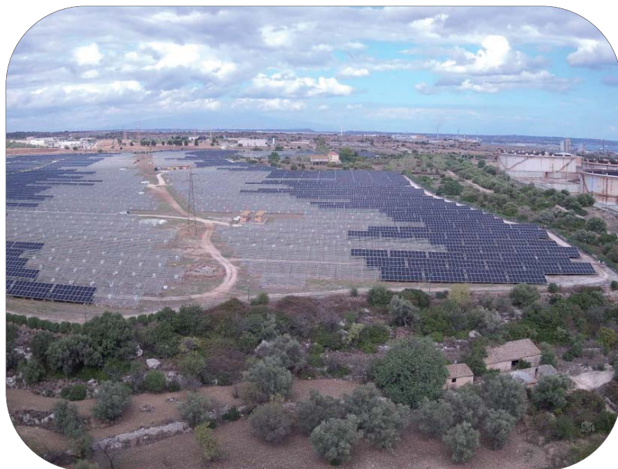
Figura 7 Impianto di Priolo
